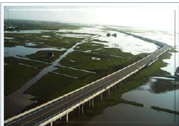
ภาพที่ ๙.๔๒ สะพานเฉลิมพระเกียรติ
