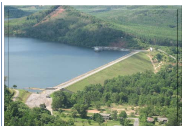
อ่างเก็บน้ำคลองสะเดา
