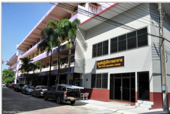
อาคารเรียน 1 (อาคาร 77 ปี)
